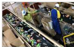
廃棄物の選別装置 (リサイクル装置)
