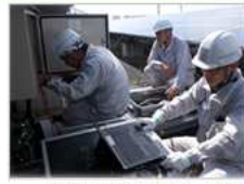
発電所の検査サービス
