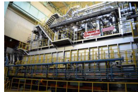
【完成した新加熱炉】
