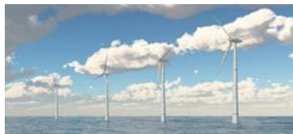
【風力発電設備外観】
