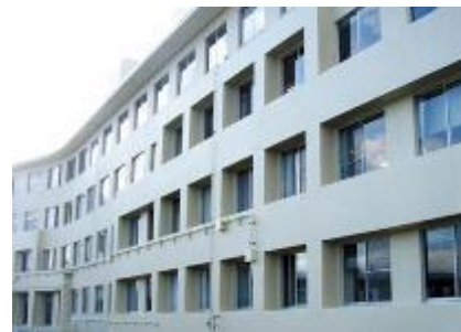
耐震補強工事
