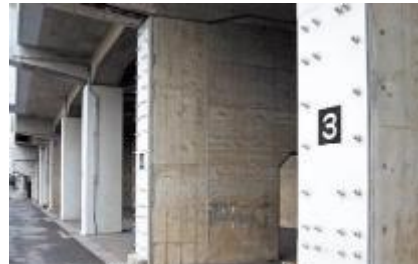
一面補強工法 (鉄道高架橋等の耐震補強)
