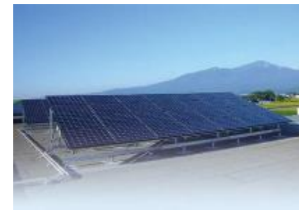
太陽光発電システム設置
