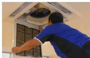
抗菌・抗ウイルスフィルター (ラフエイド) の設置
