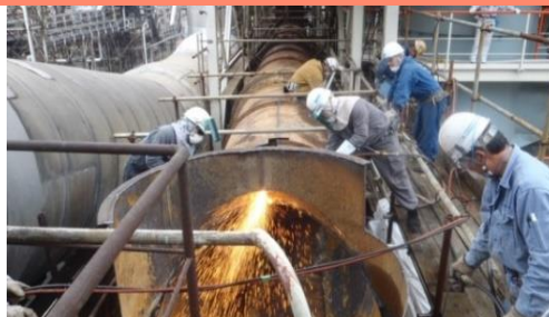
プラント ガス解体
