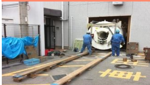
壁面切断・MRI撤去
