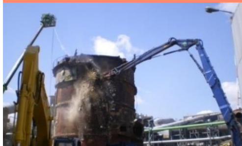
プラント 重機解体
