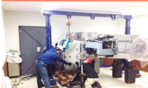
リニアック解体搬出
