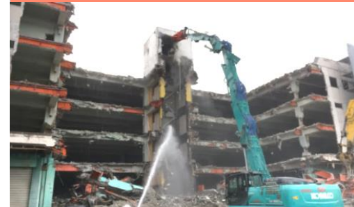
鉄筋コンクリート造解体
