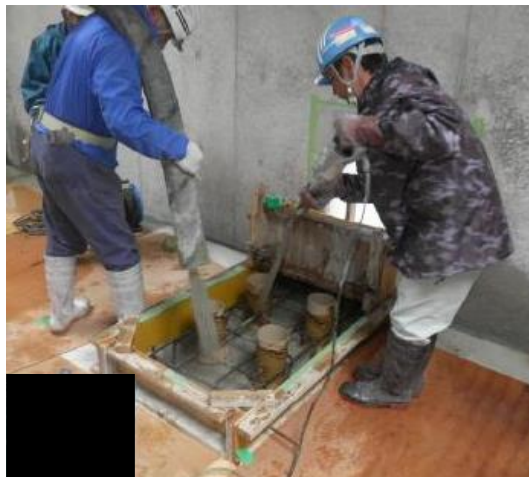
<フロキュレーター駆動部の基礎築造工事の作業風景>
