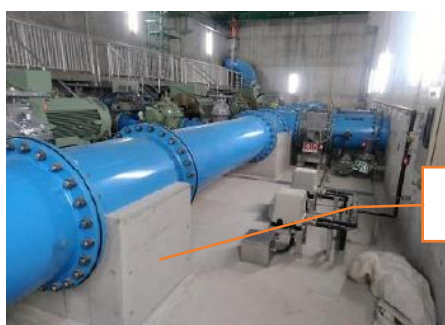
配管コンクリート巻の例
