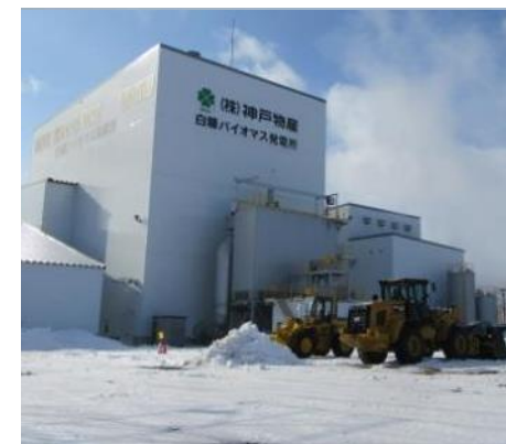
自社木質バイオマス発電所
