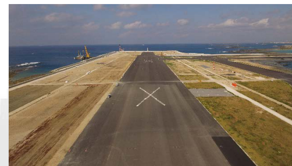
那覇空港滑走路増設4工区舗装等工事
