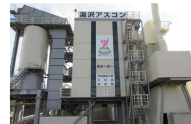
湯沢合材工場
