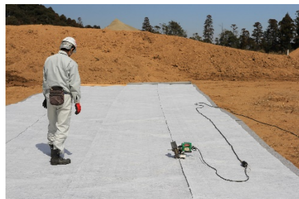
平地施工状況
