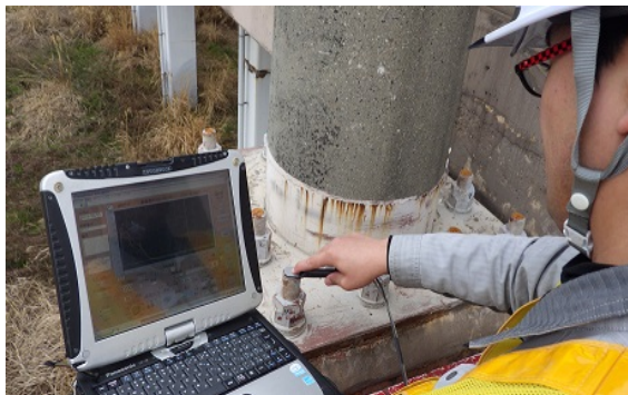
現場アンカー検査状況
