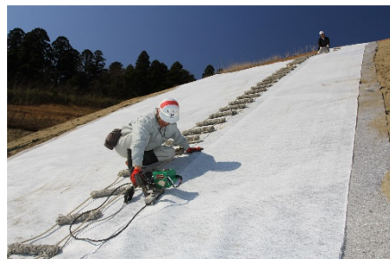
斜面施工状況
