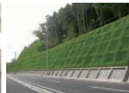
GTフレーム工法(法面工事)
