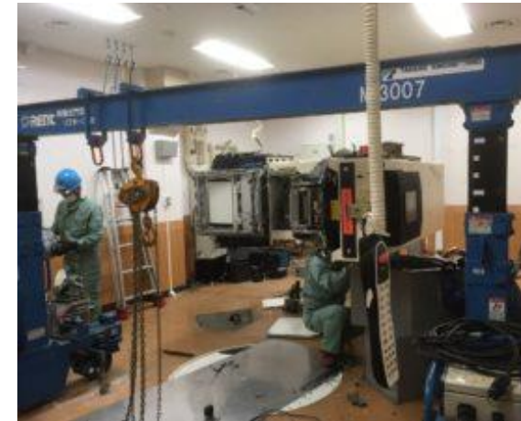
【屋内での解体作業状況】
