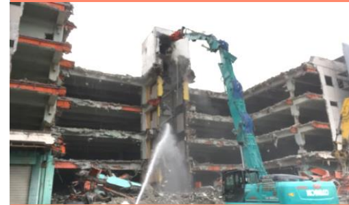
鉄筋コンクリート造解体
