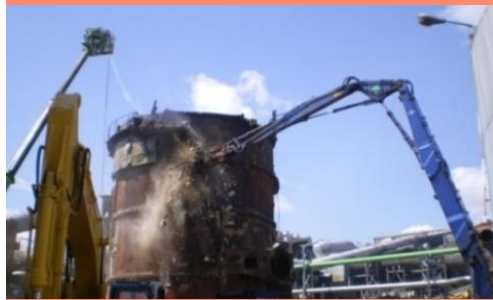
プラント 重機解体
