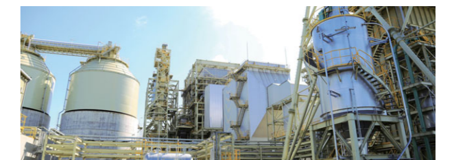
仙台パワーステーション(株)の火力発電所
