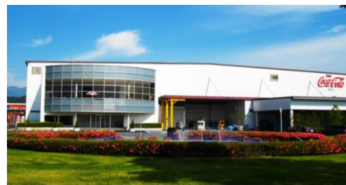
蔵王工場 新ライン建設中
