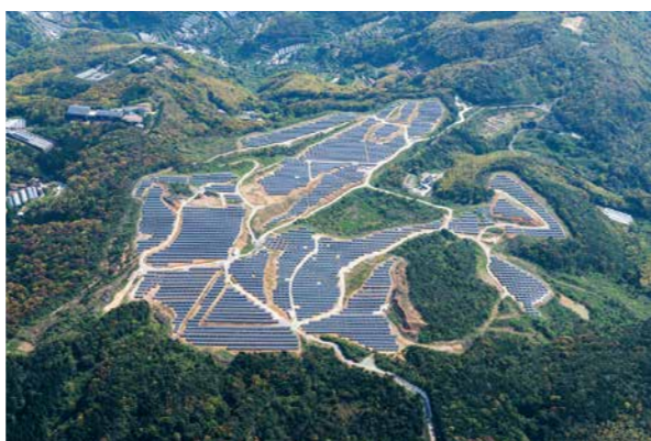
長崎手原メガソーラー発電所
