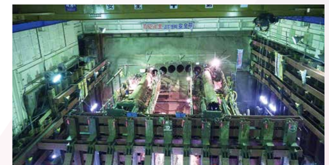
パイプルーフ施工状況
