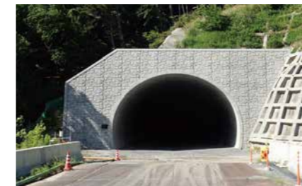
中部横断自動車道八木沢トンネル工事 国土交通省関東地方整備局
