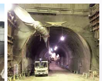
防音ハウス内のトンネル掘削状況
