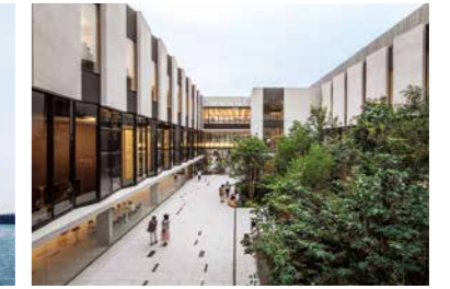
東京音楽大学 中目黒・代官山キャンパス (戸田ビルパートナーズ:ビル管理)
