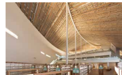
ミライオン図書館、大村市歴史資料館建設工事 長崎県大村市
