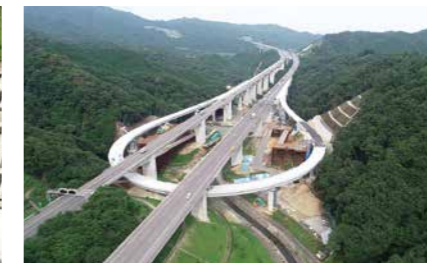
新名神高速道路 亀山西ジャンクション ランプ橋(下部工)工事 中日本高速道路(株)
