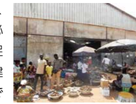
中央市場(解体前)
