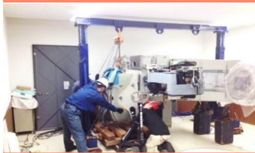
リニアック解体搬出
