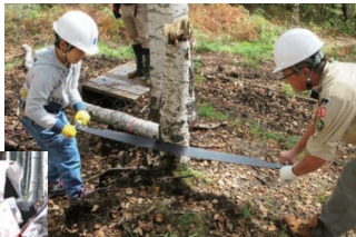
枯れた樹木を伐採する様子 (長野県王滝村)
