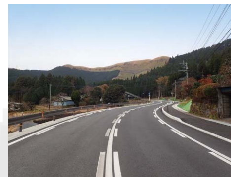
災害復旧古城地区舗装工事
