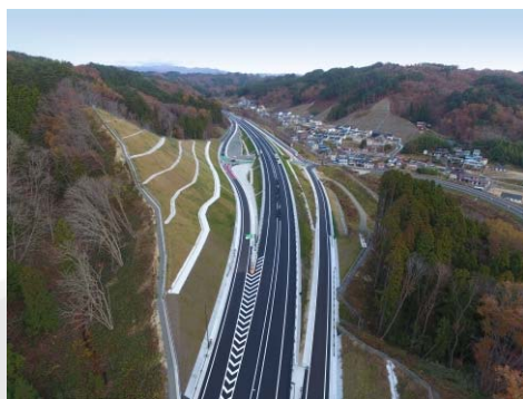
国道45号宮古地区舗装工事
