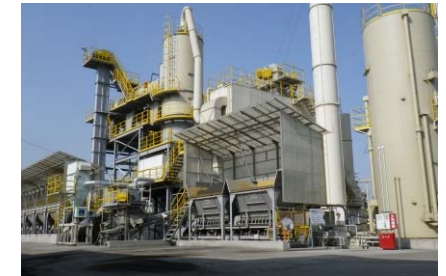
倉敷合材工場
