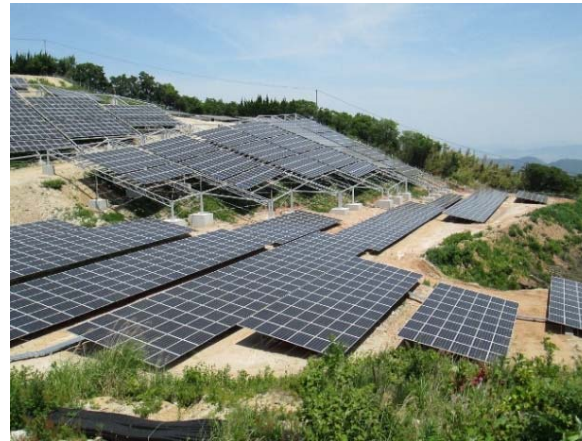
Ichigo Takamatsu Kokubunjicho Nii ECO Power Plant (Kagawa)
