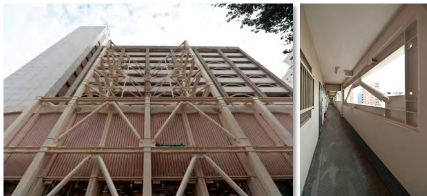
マンション耐震補強工事の施工事例
