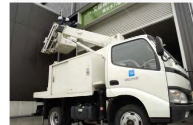
修理・保守点検の様子
