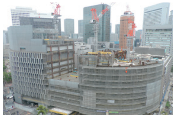
建て替え工事中の阪神梅田本店(2017年5月撮影)
