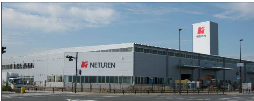
尼崎工場[2007(平成19)年10月～] での熱処理事例
