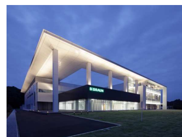
ピー・ブラウンエースクラップ株式会社 栃木工場新築工事(栃木県)
