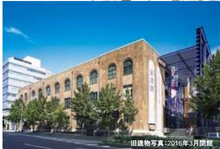
新風館再開発プロジェクト
