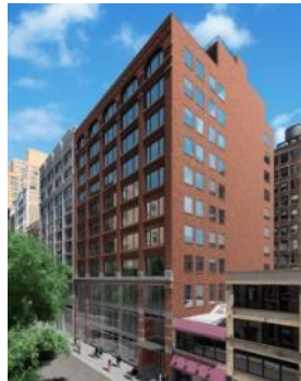
リニューアル工事後の竣工イメージ
