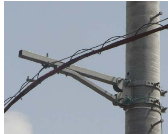
(施工例)ブロードバンド用金具
