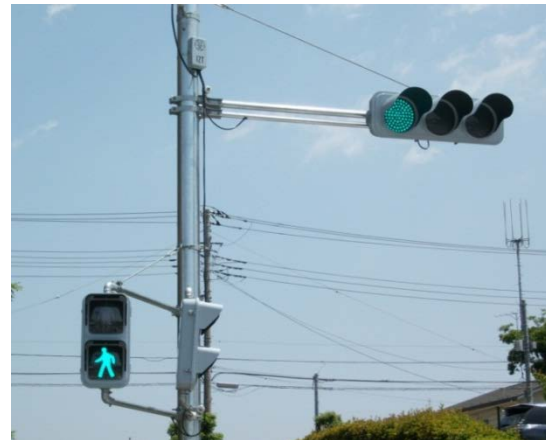
(施工例) 信号灯器取付金具
