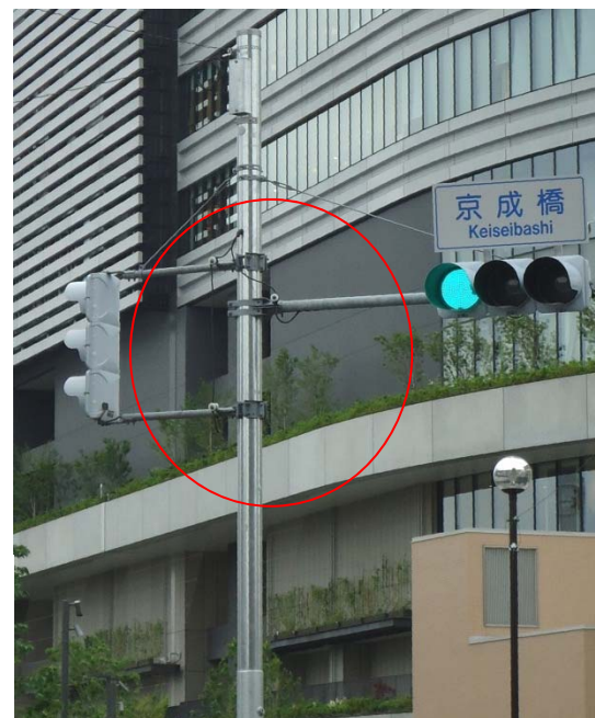
(施工例) 信号灯器取付金具
