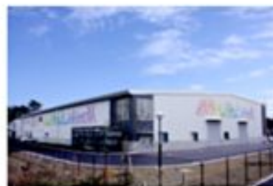
生活支援ロボット安全検証センター
