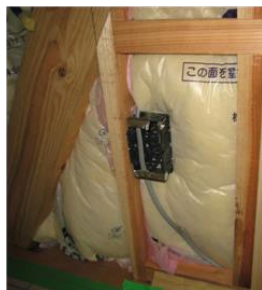
グラスウール施工事例
