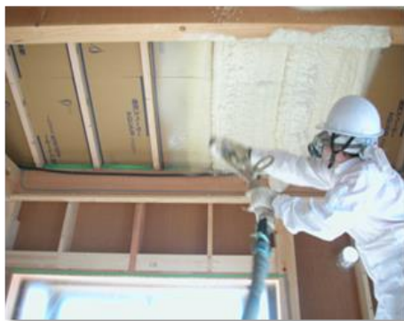
アクアフォーム施工事例
