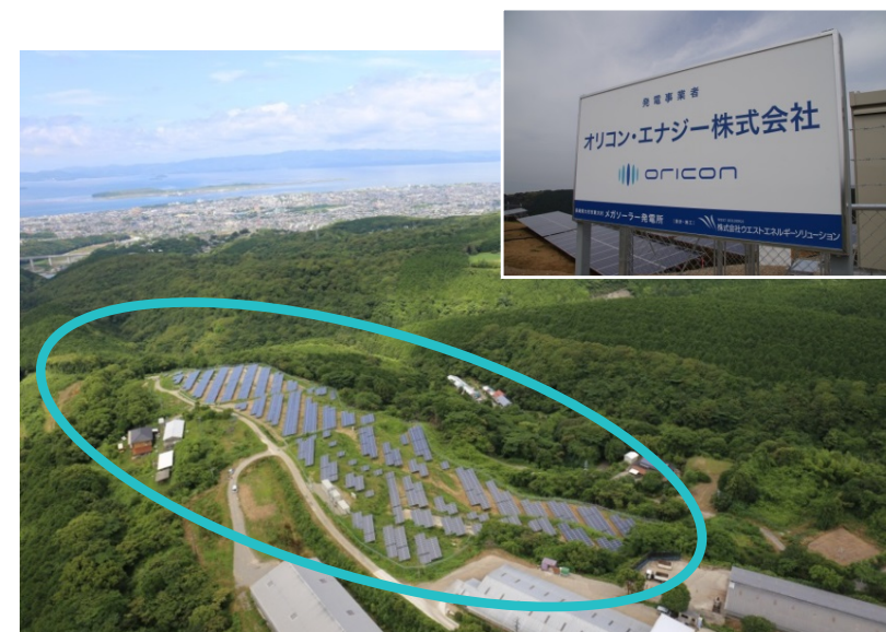
長崎県大村市の太陽光発電所
