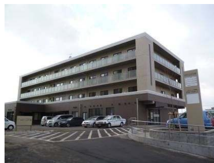
石巻市津波避難ビルに認定
