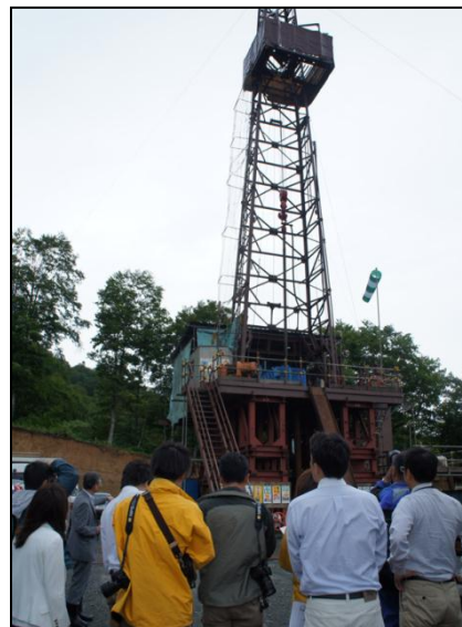
秋田県小安地域における掘削風景
