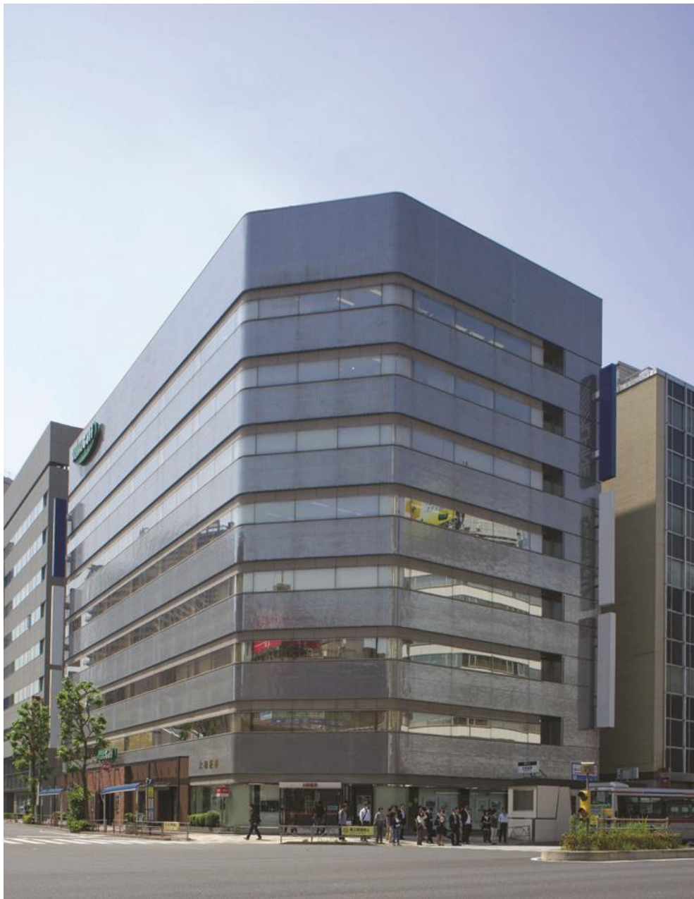
大手町建物五反田ビル 外観写真
