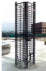
高強度せん断補強筋1275
