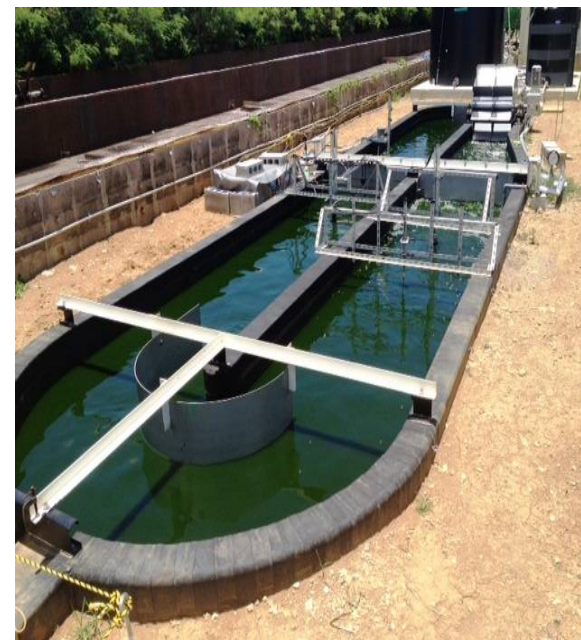
屋外大型培養槽@沖縄県石垣市
