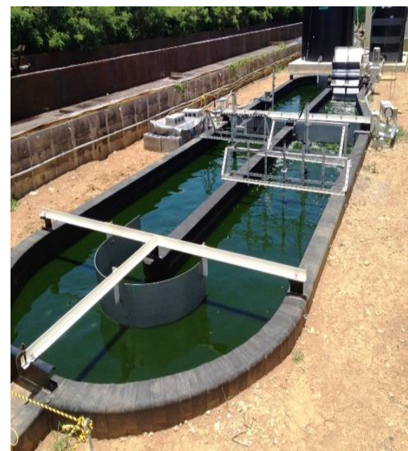
屋外大型培養槽@沖縄県石垣市
