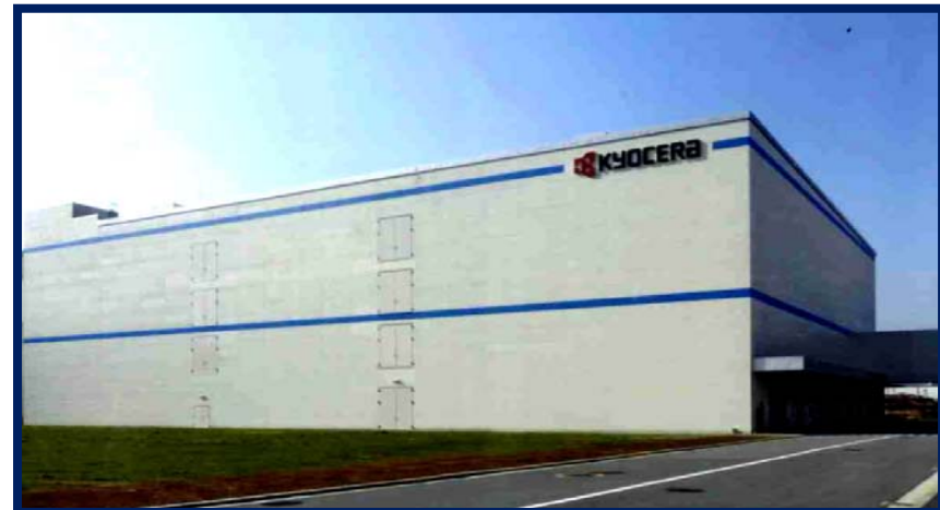
京セラドキュメントソリューションズ(株) 三重県玉城工場 第6工場
