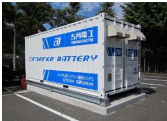
パッケージ型蓄電池システム
