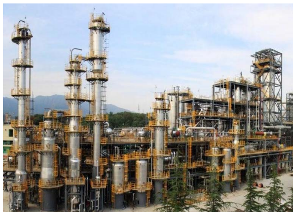
BPA製造設備
