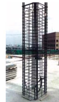
高強度せん断補強筋1275
