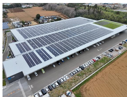
ロジスクエア成田 屋根上パネル (俯瞰)
