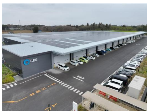
ロジスクエア成田 屋根上パネル
